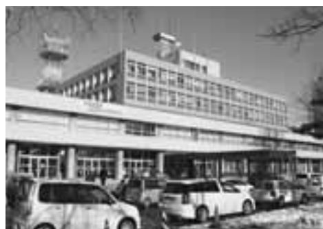
耐震改修が行われる市役所本庁舎
