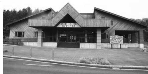
山花公園オートキャンプ場センターハウス
