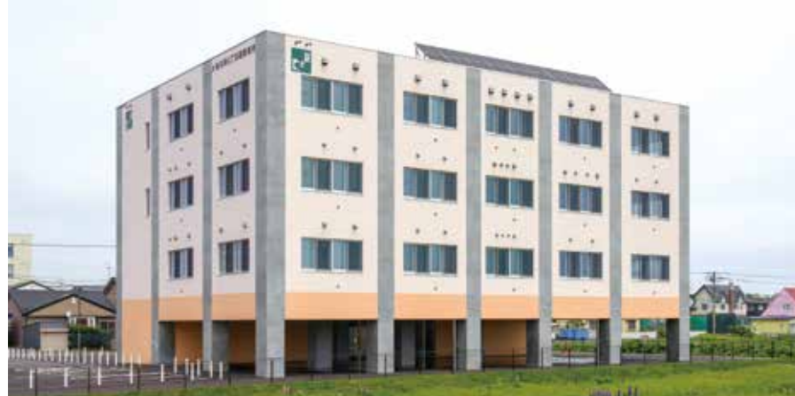
▲1階は津波が通り抜けるピロティ
