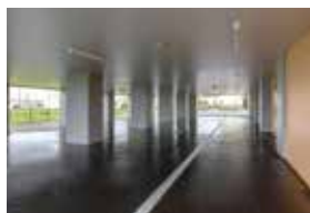
▲1階は津波が通り抜けるピロティ
