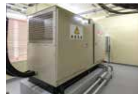
▲停電時でも暖房や照明が利用できるよう非常用発電設備を設置
