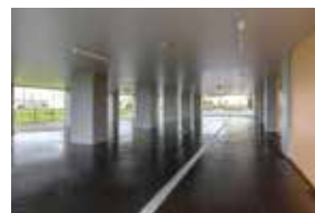
▲1階は津波が通り抜けるピロティ
