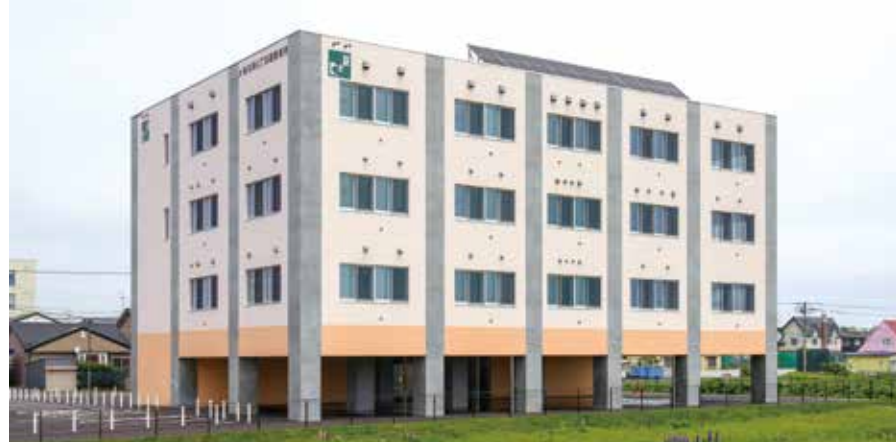
▲1階は津波が通り抜けるピロティ
