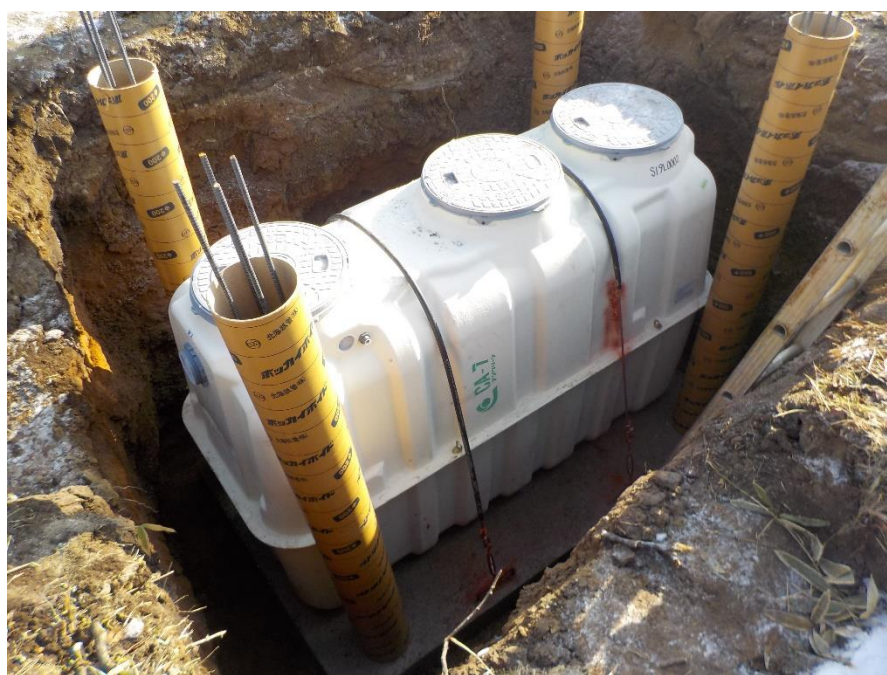
図 3-3-1 合併処理浄化槽（設置中の様子）
