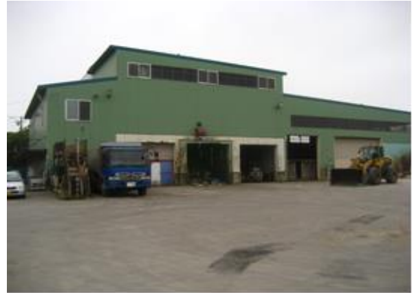
粗大ごみ処理センター
