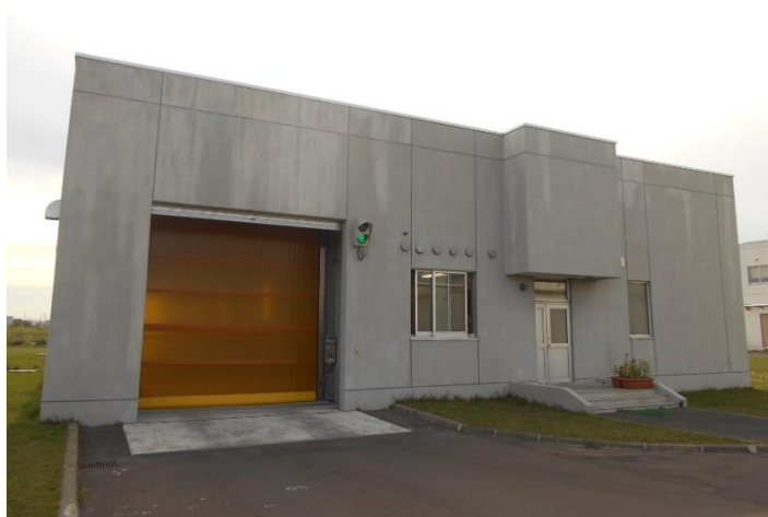
図 3-1-3 共同汚水処理施設
