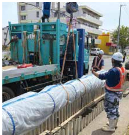
▲新しい水道管を布設している様子
