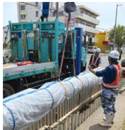
▲新しい水道管を布設している様子
