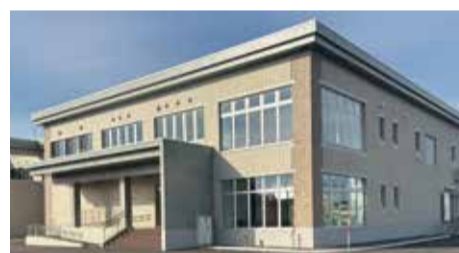
新愛国浄水場▶
