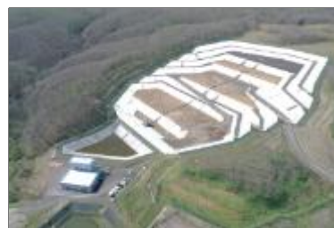
最終処分場の全景 (令和6年5月撮影)
