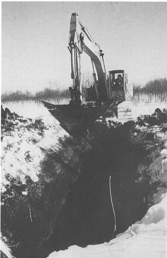
写真7. 釧路市安原での人工池の掘削 (1986.1.16)
