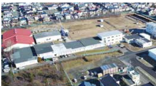
▲現在の愛国浄水場の外観
