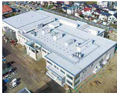
▲新しい愛国浄水場の外観
