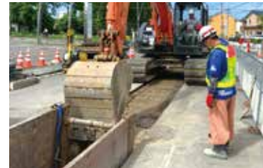
▲老朽管改築工事
