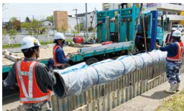
▲水道管入れ替え作業の様子
