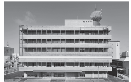
釧路市役所防災庁舎
