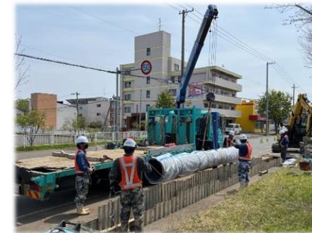
水道管路整備の様子
