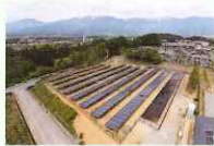
リユース品を使用した発電所
