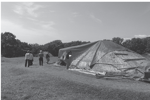
北斗遺跡竪穴住居再復元 工事見学会・屋根ふき体験会（2015年8月9日）
