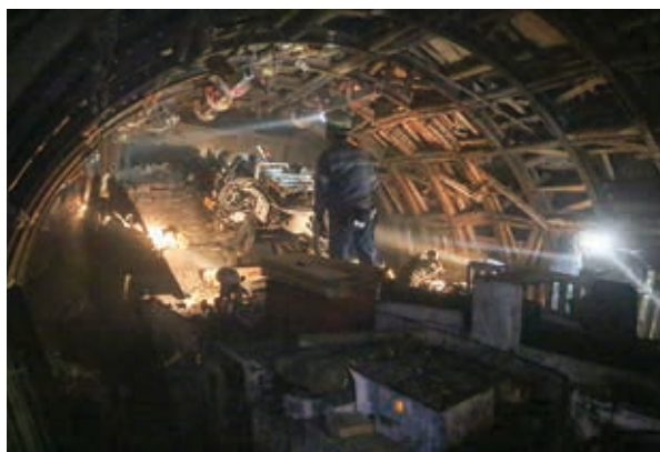
用採煤聯合機(連續採煤機)挖掘坑道
