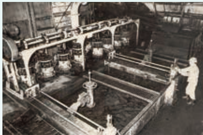
空氣跳汰(Baum jig)選煤機(太平洋煤礦)
