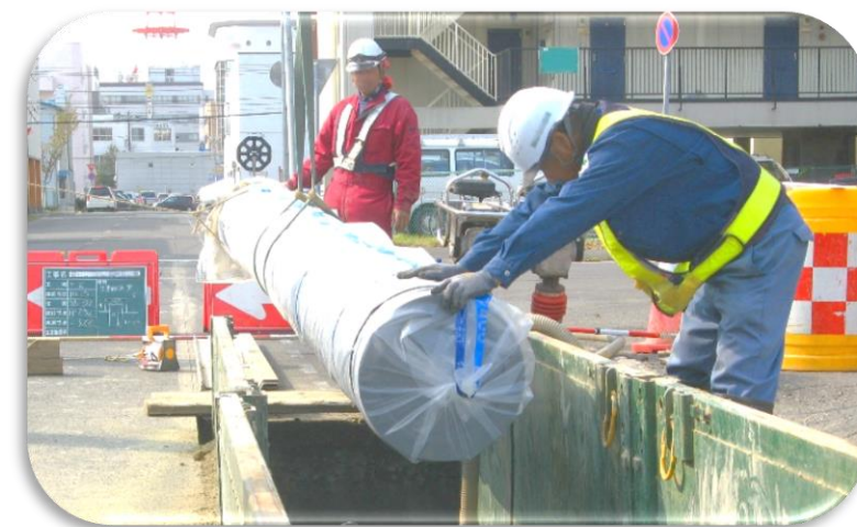
老朽管更新状況
