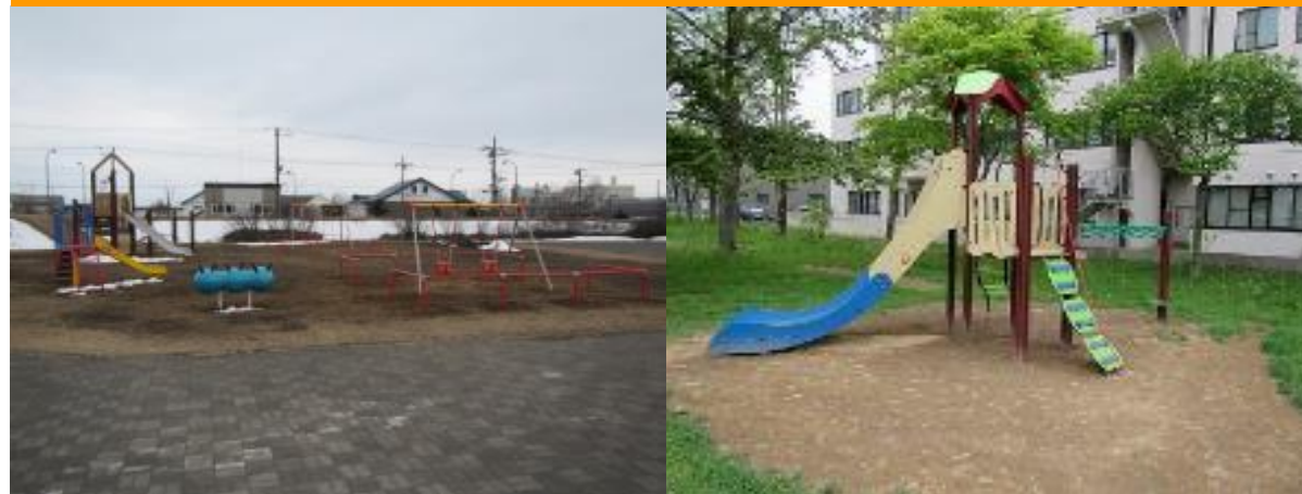
長寿命化に向けた改修
