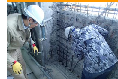
耐震補強工事
