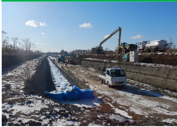
星が浦川河川改修工事
