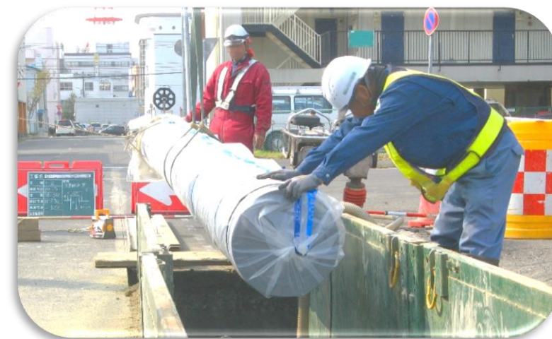
老朽管更新状況
