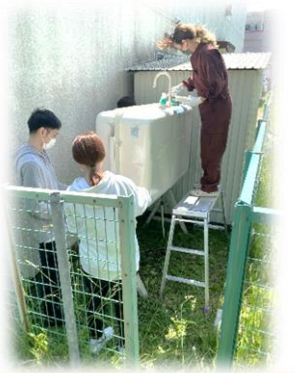
灯油タンク塗装作業の様子
