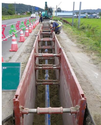
水道管路施工状況
