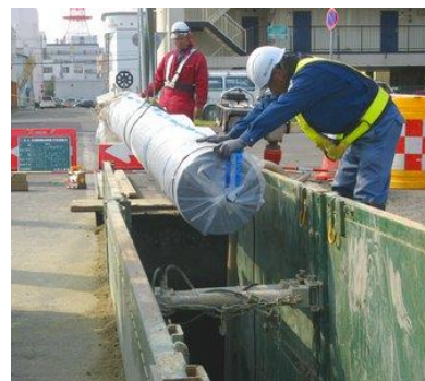
老朽管の更新
