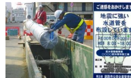
水道老朽管の更新
