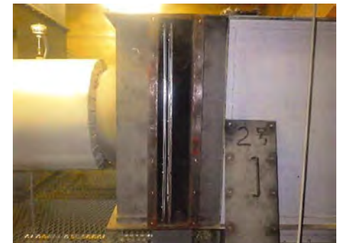
(写真2) 阿寒町斎場集塵メッシュスクリーン取替
