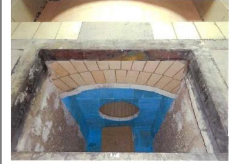
(写真2) トップライト廻りシーリング打ち替え工事
