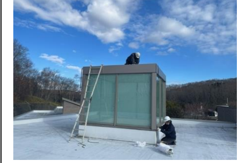
(写真2) トップライト廻りシーリング打ち替え工事
