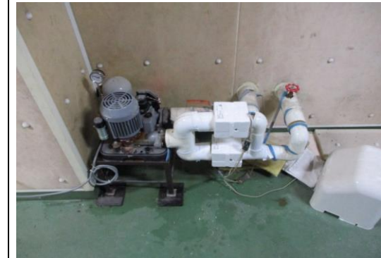
(写真2) 阿寒町斎場水道配管修繕
