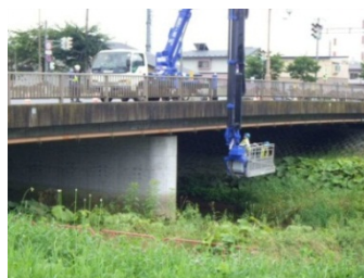
橋梁点検診断の様子
