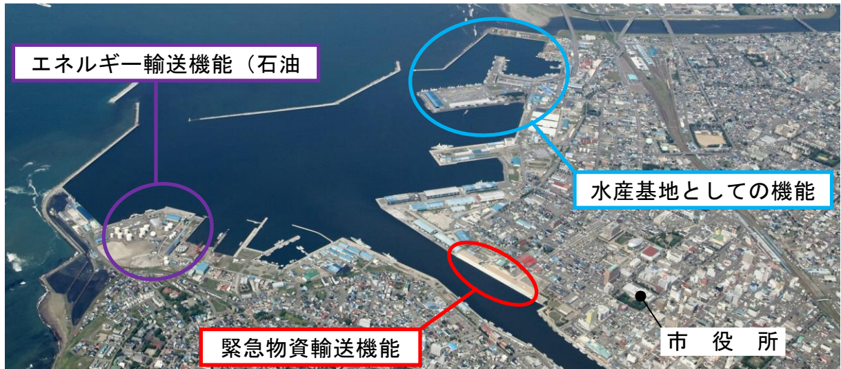
図 3-1-1(1) 被害想定箇所（東港区）
