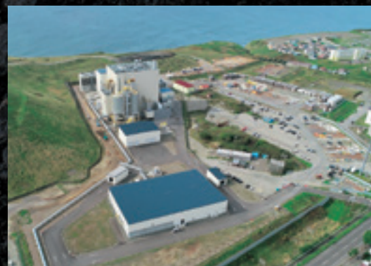
「釧路火力発電所」
