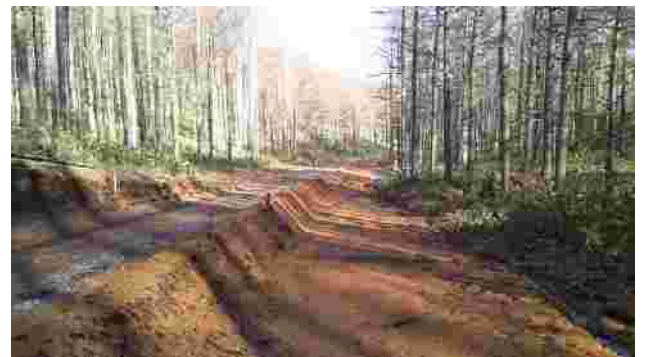
標茶町で整備した林業専用道 阿寒飽別でも来年度より整備予定
