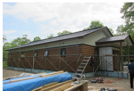
▲くしろ・ねむろ「木づな」の家協議会によるカラマツ住宅外観
