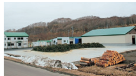
釧路地域のトドマツの枝葉の 精油抽出プラント
