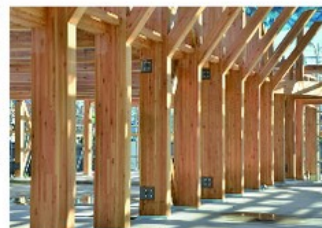
大断面構造用集成材施工状況
