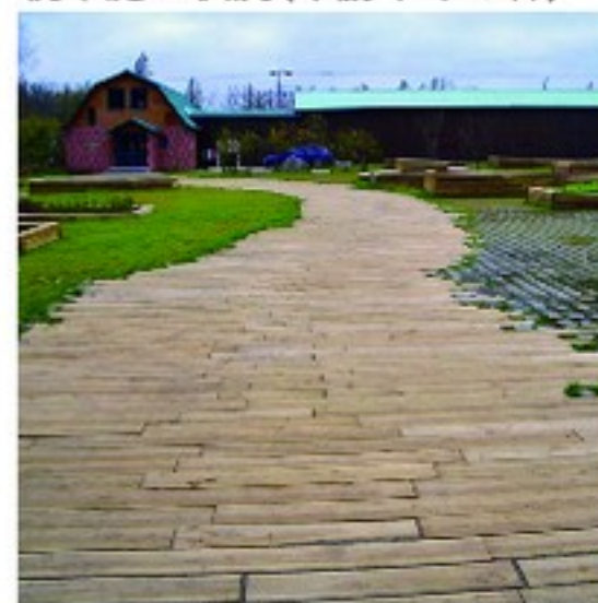
枕木施工状況(十勝千年の森)
