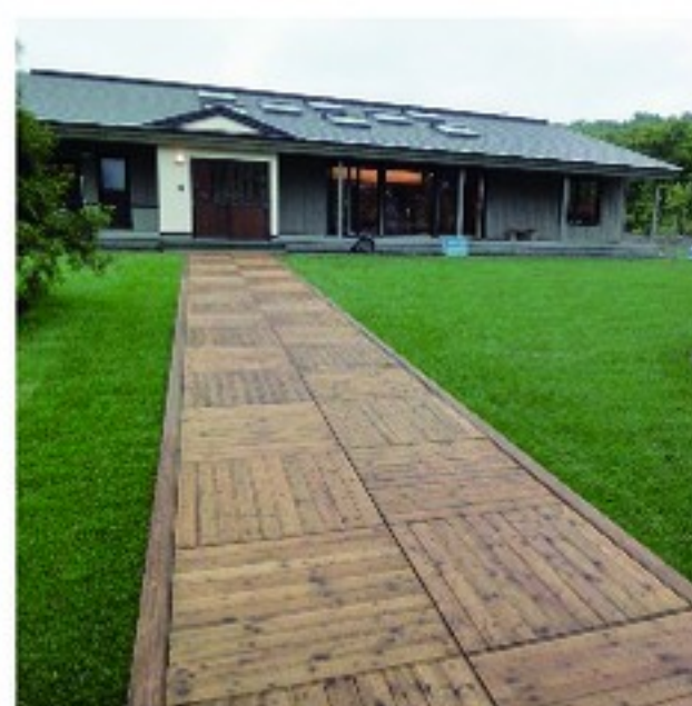
モクレンガパネル施工状況(O邸)
