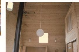
羽目板(カラマツ)施工状況
