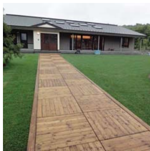
モクレンガパネル施工状況(O邸)
