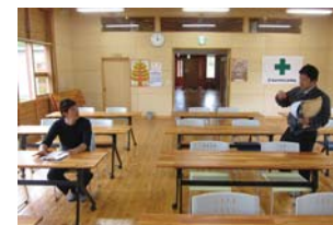
フローリング(カラマツ)施工状況 (林業・林産従事者研修センター)
