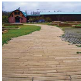
枕木施工状況(十勝千年の森)
