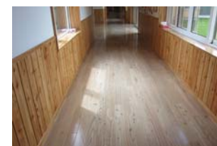
複合フローリング鶴ハード(カラマツ) 施工状況(大楽毛よしの幼稚園)
