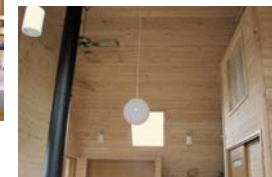
羽目板(カラマツ)施工状況
