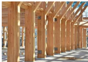
大断面構造用集成材施工状況
