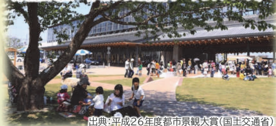
【事例】日向市駅前広場〔日向市〕 （駅前広場と一体となった駅前オープンスペース）
