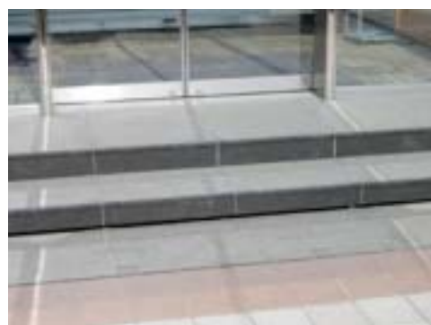
▲ 階段のある北大通店舗入口
