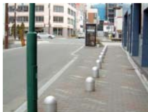
▲ 歩道幅員の半分以上を占める車止め
