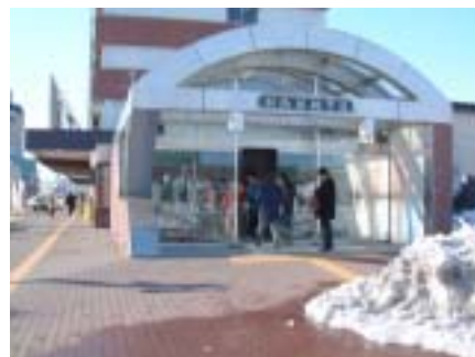
▲ 地下道入口 ( すべて開き戸 )
