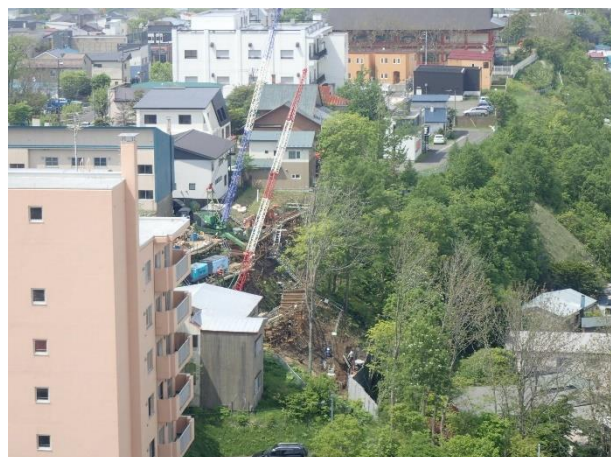
【土砂災害対策工事】
