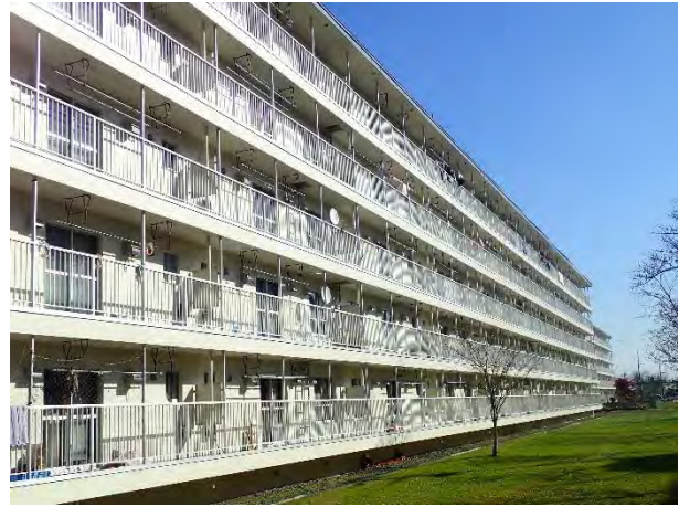
【美原公営住宅】
