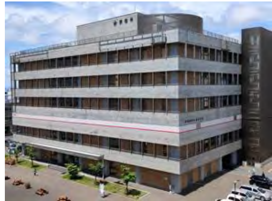
【釧路市役所防災庁舎】
