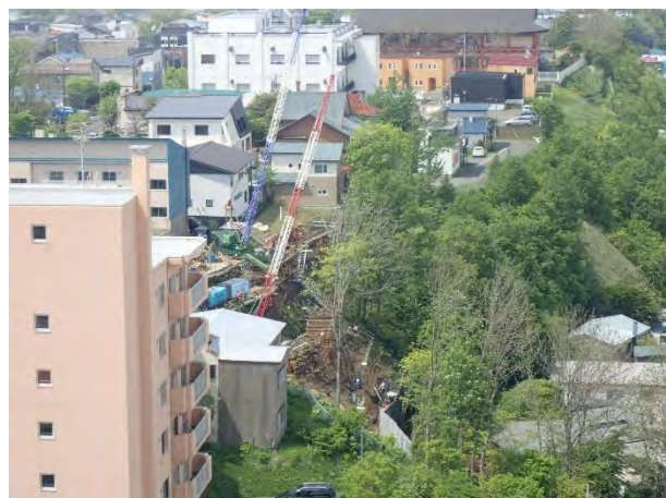
【土砂災害対策工事】
