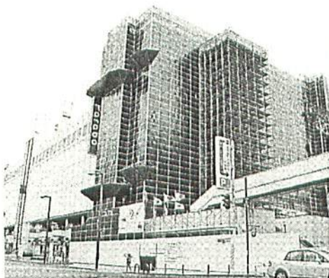
北見市役所の移転に向けて改修工事が進む JR北見駅近くの商業ビル
