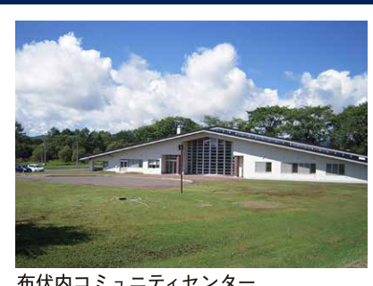
布伏内コミュニティセンター
