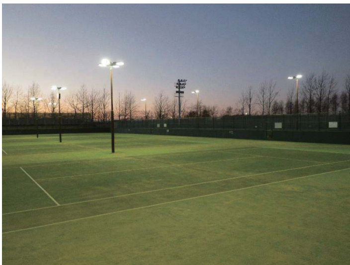
（釧路市民テニスコート 照明設備更新工事）
