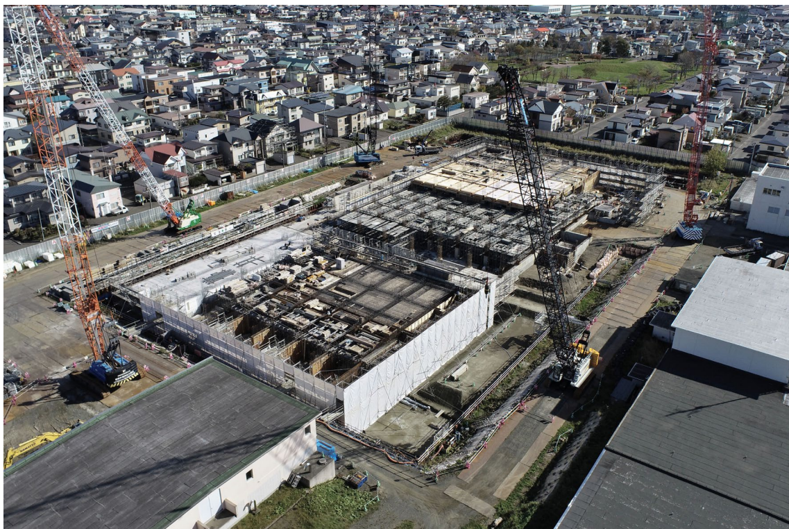
愛国浄水場更新事業 第二期工事
