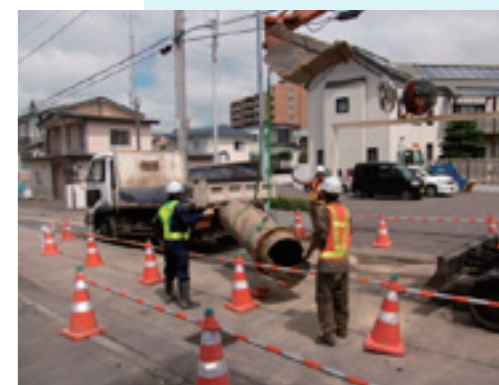
配水管布設工事
