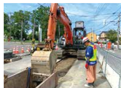
▲老朽管改築工事
