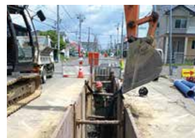
▲老朽管改築工事
