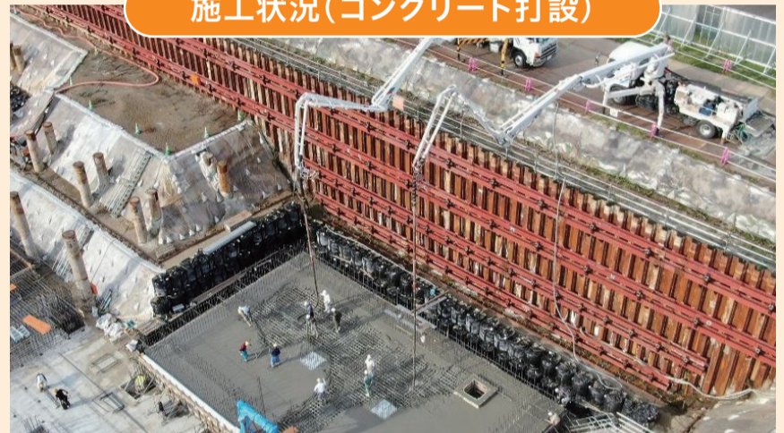
施工状況(コンクリート打設)
