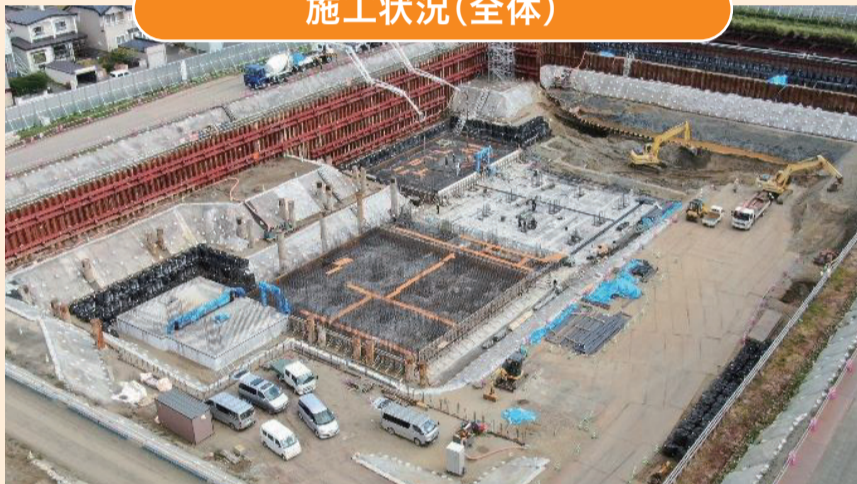
施工状況(全体)
