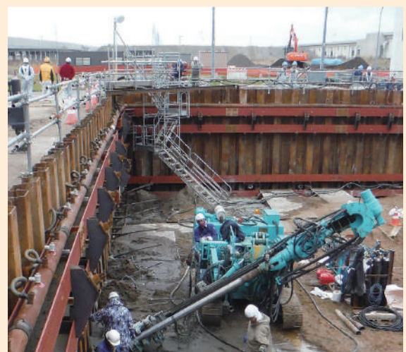
施工状況②
