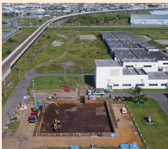
施工状況①
