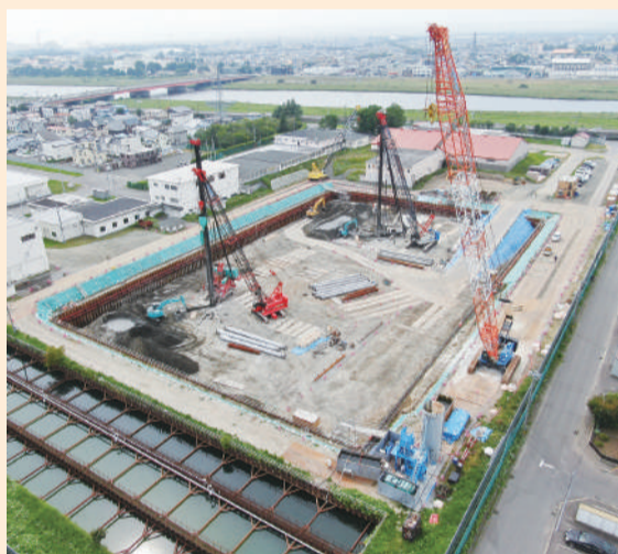
基礎杭工事②
