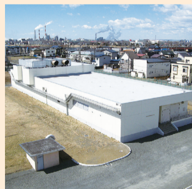
▲耐震化された新愛国浄水場送配水ポンプ場(平成28年度完成)
